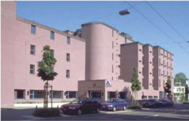
Sanierung JH Zürich
