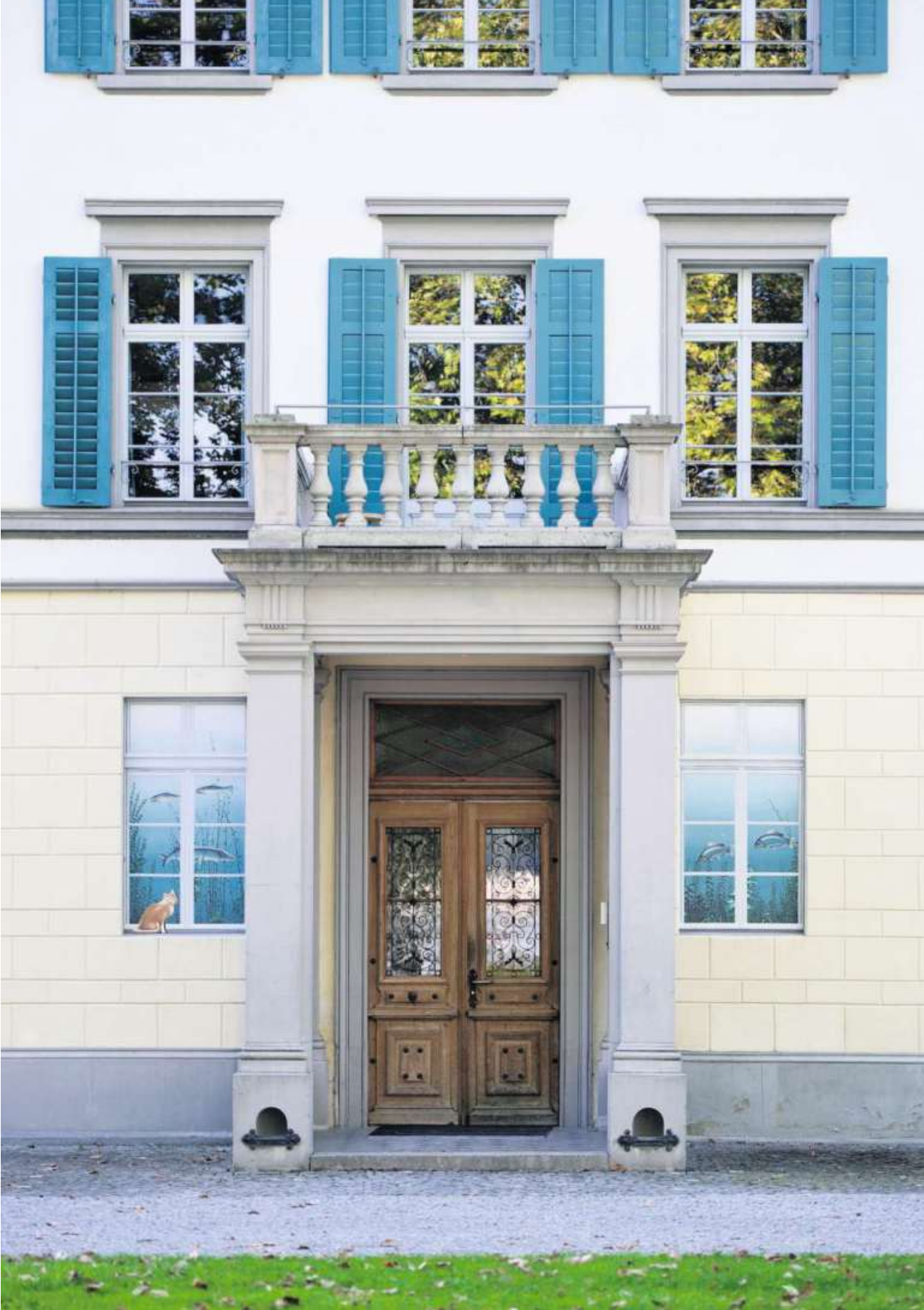
Richterswil: ehemalige Seidenfabrik am Ufer des Zürichsees. SIMON TANNER / NZZ
