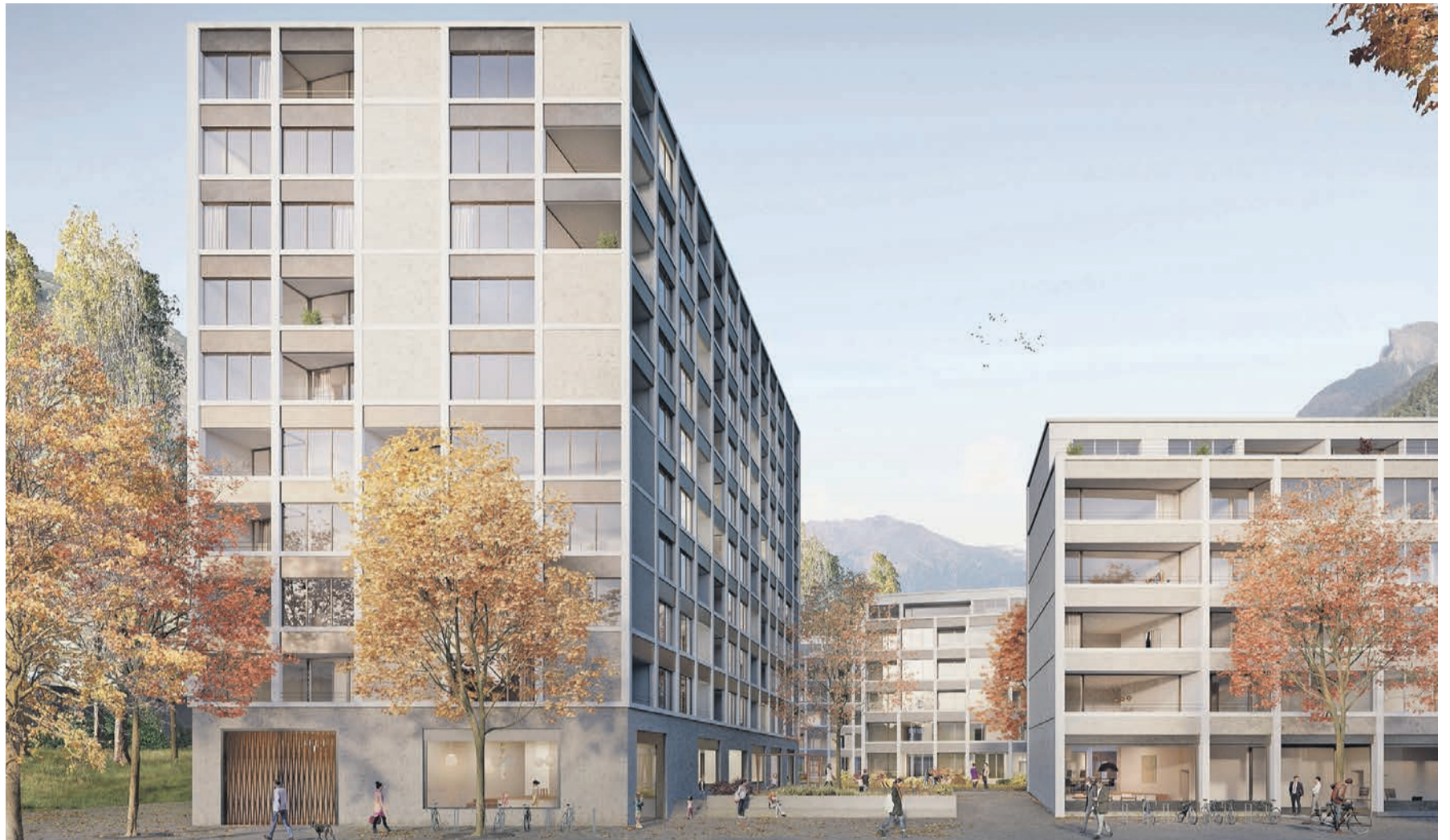
Hoch hinaus. Eines der vier Wohngebäude der Überbauung Litterna wird neun Stockwerke haben.
