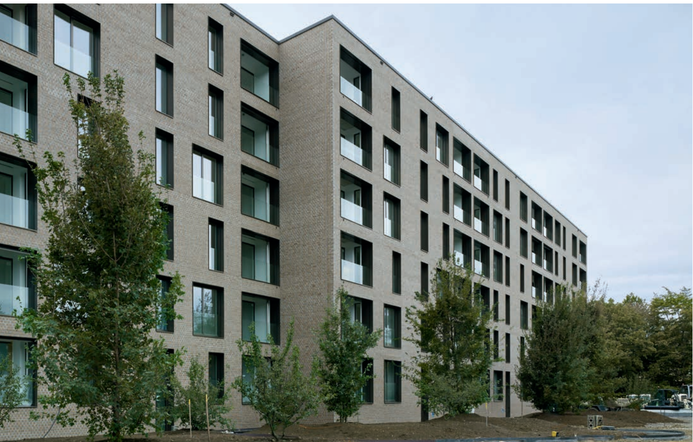
Aussenansicht Haus B. Die Wohnungen liegen im mittleren Preissegment. (Bild: Ruedi Walti)
