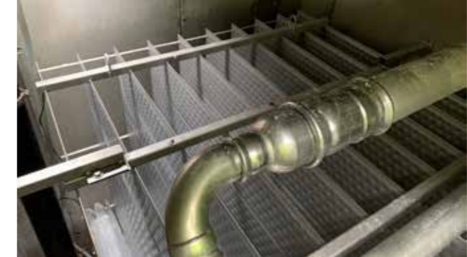
Der Wärmetauscher im Feka-Schacht entzieht dem Abwasser die Abwärme.
