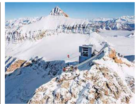
Skigebiet Les Diablerets: Der Scex Rouge mit der imposanten Hängebrücke.
