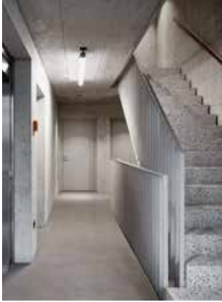
Treppenhaus im neuen Wohngebäude auf Baufeld B.
