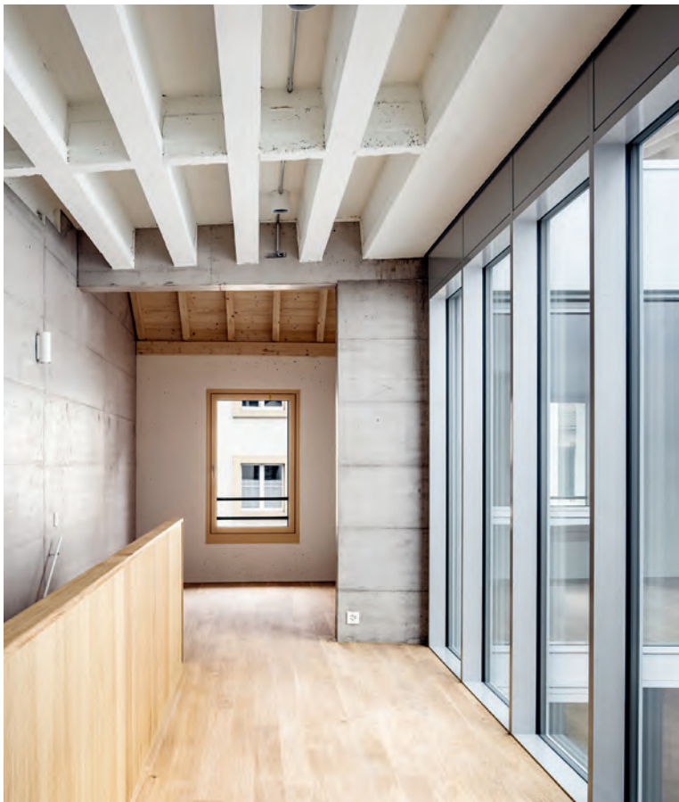
Im Obergeschoss zeugt die alte Rippendecke vom früheren Kinosaal.
